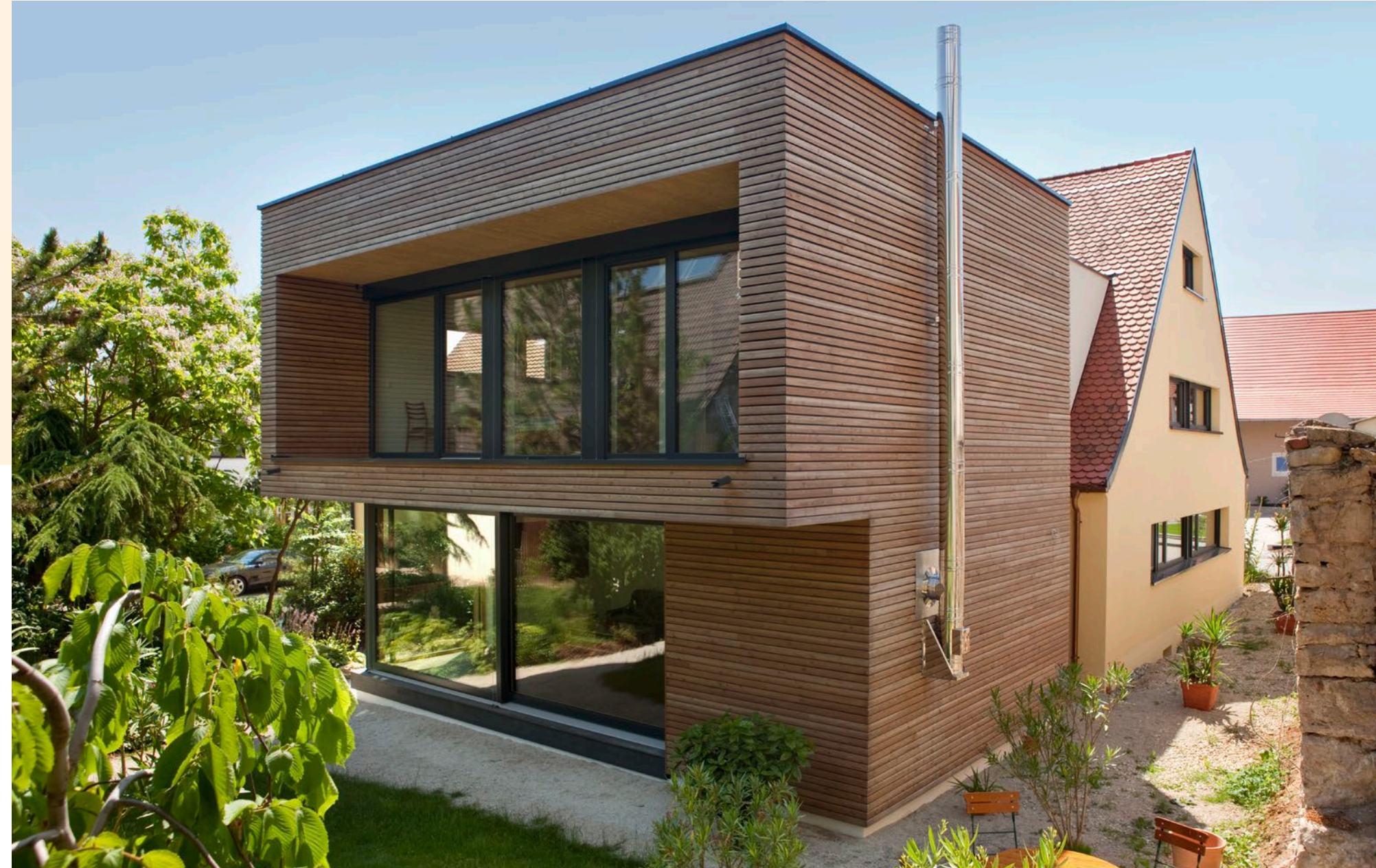
Gelungene Verwandlung: Der Anbau auf der Rückseite wurde in moderner Holz-/Glasoptik realisiert, ohne die traditionelle Fassade auf der Frontseite zu stören
