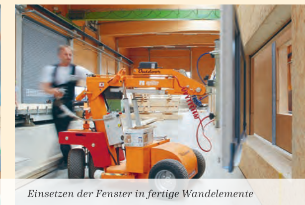
Unsere Weinmann Anlage ermöglicht die präzise, teilautomatische Vorfertigung von Wandelementen
